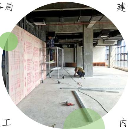
建设，该项目施工内容有土建装修专业的隔墙、铺设地砖、吊顶、刮腻子、柜子安装等，安装专业的强弱电系统、消防喷淋、中央空调改造、扶梯、步梯安装等多项工作内容。
