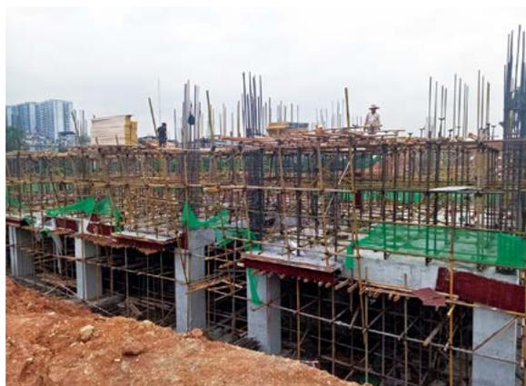
日碰头会等措施，组织施工、监理、勘测、检测等参建单位抓质量、抓安全、抓进度，保证工程各个工序的紧密搭接。在3月份连续雨天和4月份连续高温的天气情况下，组织施工、监理人员日夜抢工，研究赶工措施。在基础施工中，根据项目实际情况，在充分研究论证的基础上，采取了基础承台和柱浇筑后直接通过搭设满堂架支撑上层梁板的施工措施，基本消除雨天对填土等工作的影响，极大的加快了施工的进展，进一步确保工期目标的顺利实现。
